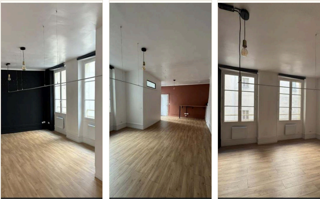
État existant avant travaux — pièce principale, profondeur et cloison, fenêtres sur cour
