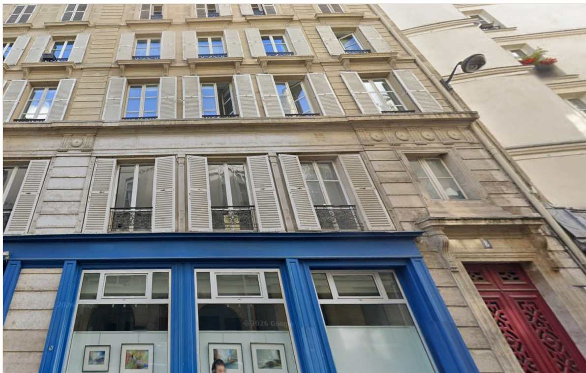
8-10 rue Bertin Poirée — double entrée, deux escaliers : deux hôtels autonomes et cessibles séparément.
