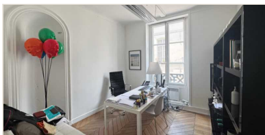
EXISTANT — PARQUET POINTE DE HONGRIE
